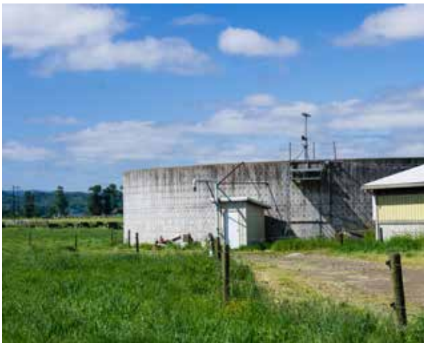
Betonsilo für Flüssigmist in einem landwirtschaftlichen Betrieb.
