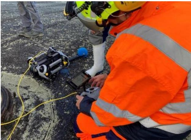
Pilotage du drone aquatique dans les canalisations © Xylem
