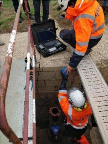
Basée sur l'innovation SmartBall®, développée par [Pure Technologies](#), entreprise du Groupe Xylem, cette opération a été menée sur une canalisation d'eau potable d'environ 16,2 kilomètres (diamètre 400mm), qui relie l'usine de traitement de Varennes au réservoir de Buxy, en Saône et Loire.
