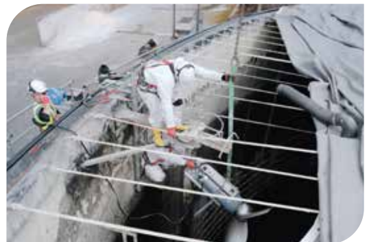
Installation Rührwerk Gärrestelager
