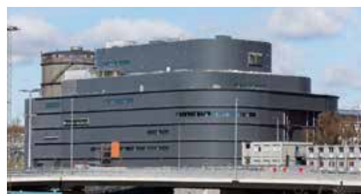
Energiayhtiö Fortumin tytäryhtiö Fortum Värme rakentaa uutta CHP-laitosta Tukholman Värtaniin, Ruotsiin.
