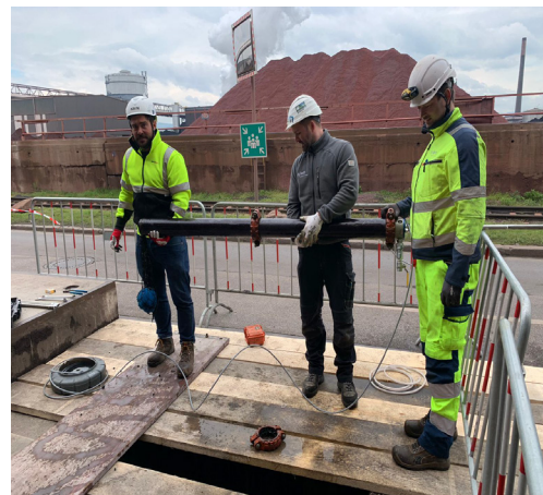
Einbringung des SmartBalls durch das Xylem Team
