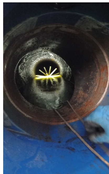
Rohrleitung mit schwimmendem PipeDiver
