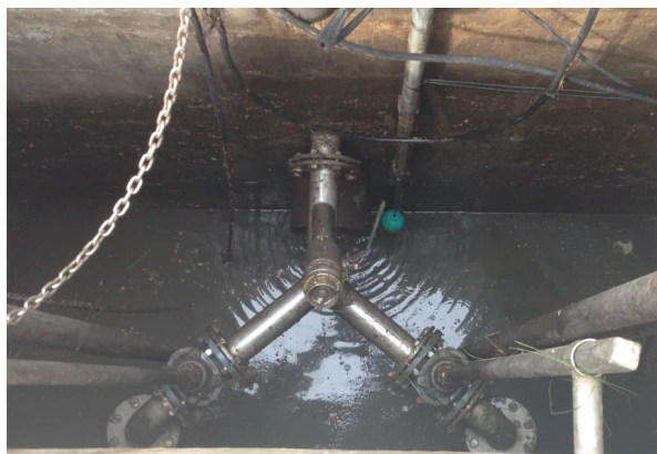
Eine Ansicht vom sauberem Pumpensumpf nach der Flygt Installation an der Pumpstation
