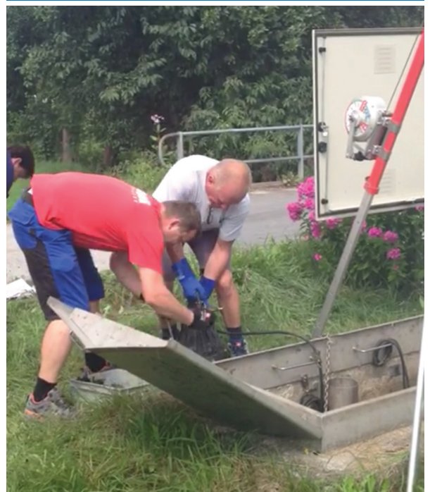
Xylem's Flygt Concertor wird installiert bei RHV Mühlthal, Österreich
