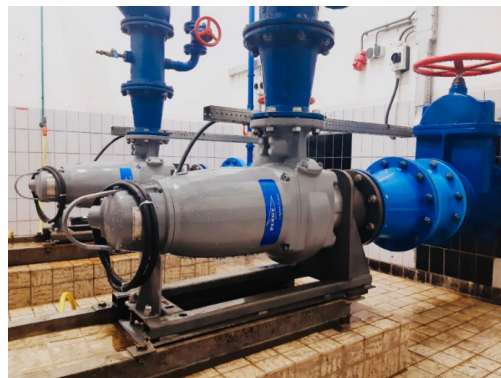
Het rioolgemaal na plaatsing van de nieuwe pompen met dezelfde betonnen fundaties, aangesloten op het bestaande leidingwerk.
