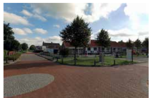
De locatie van het rioolgemaal in het dorp Dronryp, in de gemeente Waadhoeke
