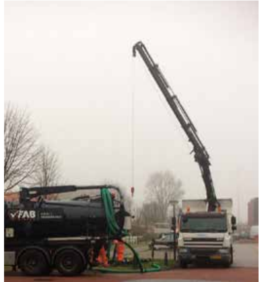
De nieuwe pomp wordt in het rioolgemaal gehesen
