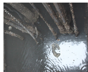
Fig 8 : Bâche de pompage après installation de Concertor
